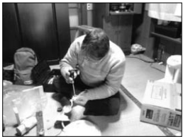
照明器具交換取り付け
